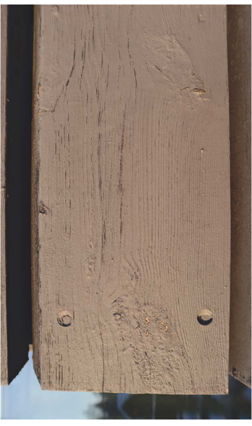
Julkisivun harmaa sävy on suojeltu. Nauloille on porattu esireiät, jolloin naulat asettuvat syvennyksiin.
